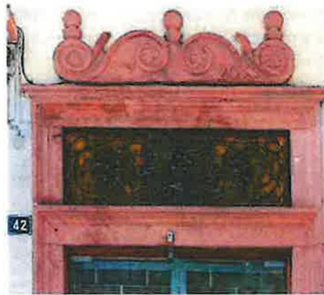
Portail au 42 rue des Chevaliers (Crédit photo : © Ralph Hammann - Wikimedia Commons)
