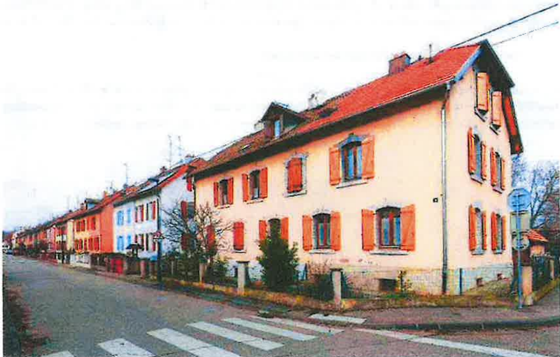
Vue partielle de la cité ouvrière, le long du boulevard Paul-Cluny © Région Grand Est – SRI – Frédéric Harster
