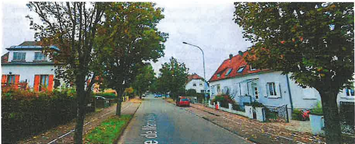
Vue de la route de Marckolsheim en entrée de ville (Source : google)
