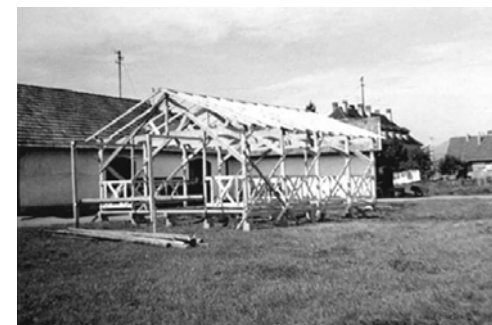
Montage d'une structure pour la Cité Kilbe © Droits réservés
