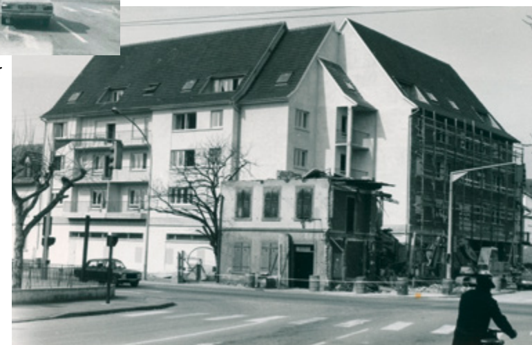
Démolition de l'épicerie Eber en 1978
