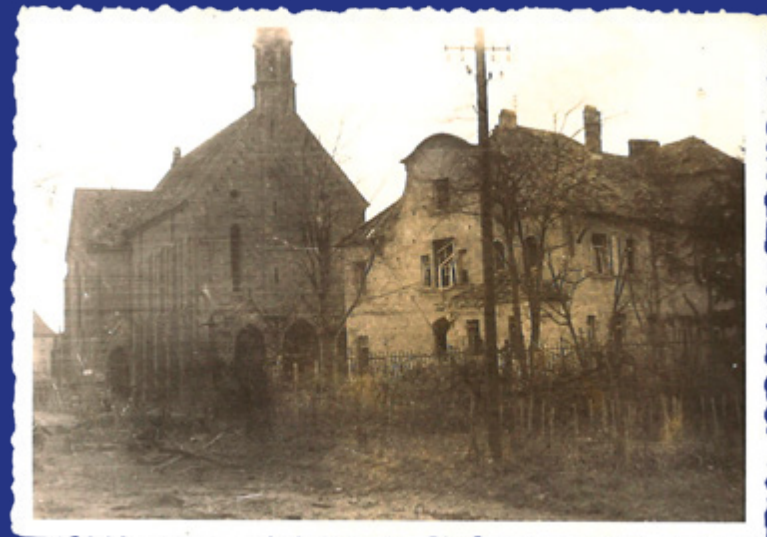
L'église Saint-Antoine, endommagée après le bombardement © Collection André Ehm
