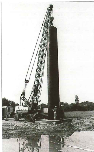
Forage du puits Oberen-Erlen (Photo L'Alsace)
