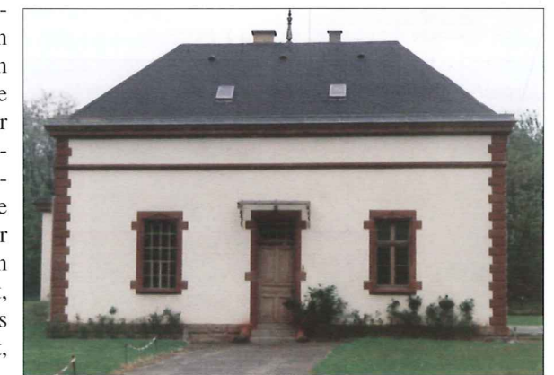
Station de pompage du Galgenfeld
