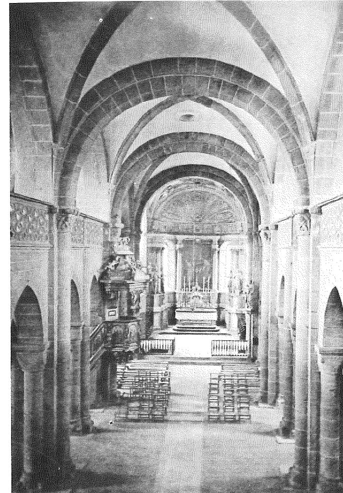
Etat de la nef avant la restauration de 1890 (démolition des tribunes)
