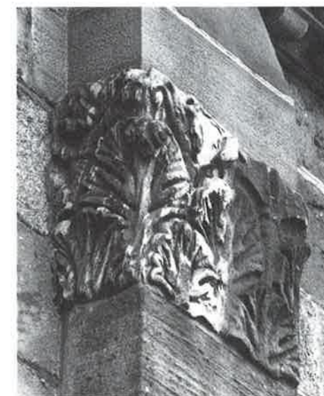
Fig.4 - Pilastre de la face nord, avec deux moitiés de chapiteaux corinthiens, vers 1085-90.
