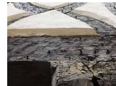
Entailles et clous visibles sur le pan de bois 7 quai des Tanneurs
