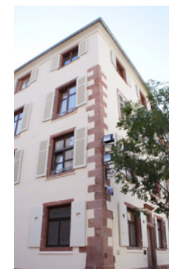
Chaînage d'angle en pierre Dernier étage en pan de bois crépi 7 place du Marché Vert
