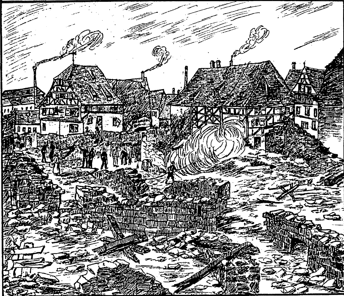
1. Gerberel. 2. Ecke der Johngasse. (Diese Brandstätte wurde von unserem Zeichner am Tage nach der Katastrophe, vom Kunbboulevard aus gesehen, an Ort und Stelle aufgenommen. Näheres s. Seite 2 unseres Blattes).
