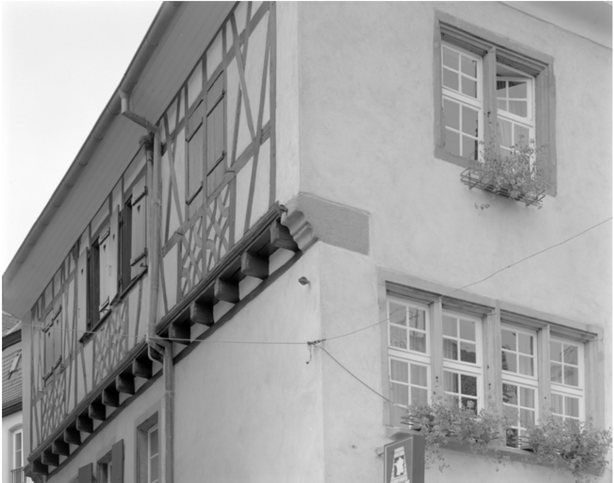
Elévation latérale sur l'impasse des Tailleurs, deuxième étage en pan-de-bois.
