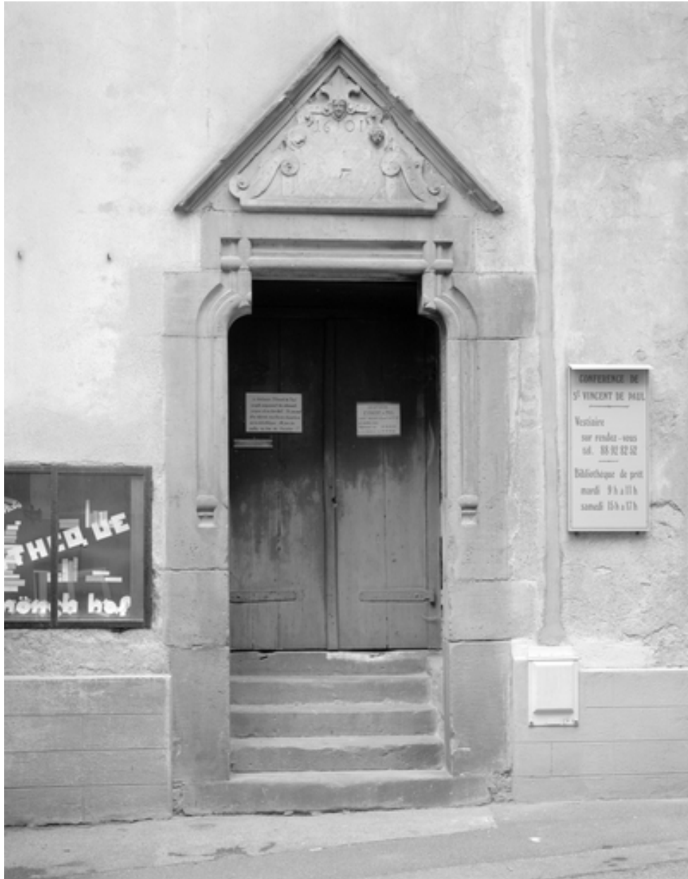
Façade sur rue : porte d'entrée avec fronton.
