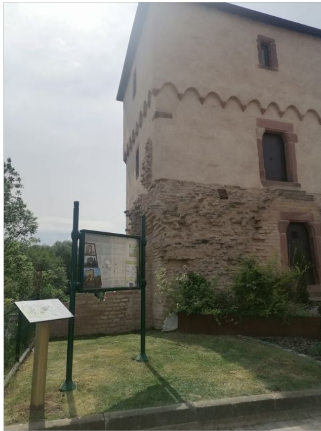
Figure 7 : Panneau installé devant la Tour des Bouchers à Lauterbourg
